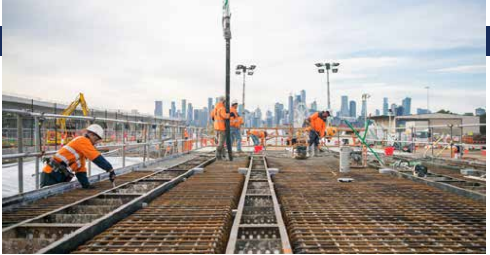
PRTTP Under Construction
